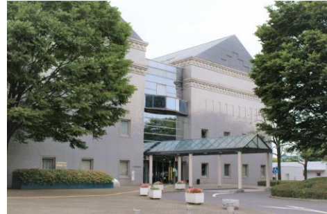
古河市役所古河庁舎
