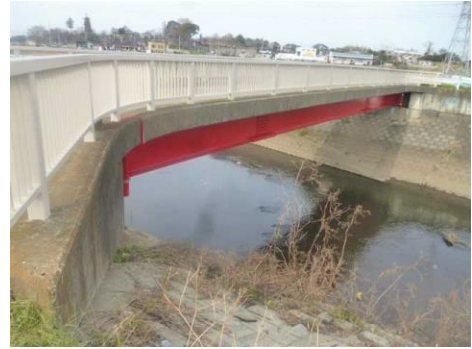
長寿命化対策を行った東諸川橋
