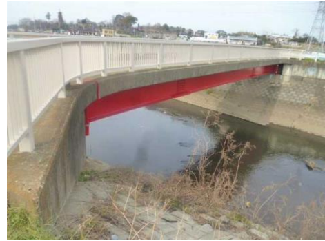
長寿命化対策を行った東諸川橋
