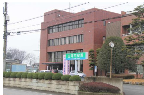
古河市役所総和庁舎
