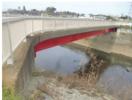
長寿命化対策を行った東諸川橋
