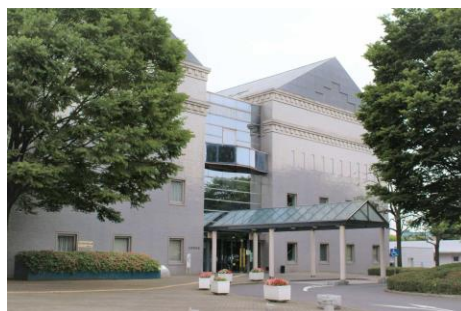
古河市役所古河庁舎
