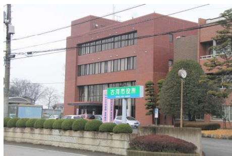
古河市役所総和庁舎
