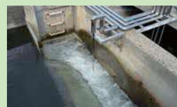
配管を通して薬を注入しています
