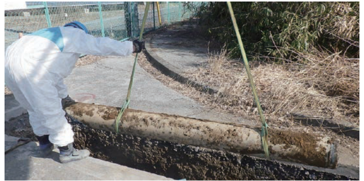
撤去された石綿セメント管
