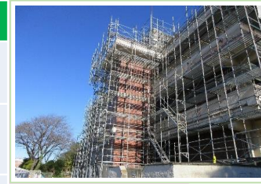
▲学校施設の修繕
