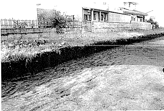
2. 調査区南壁土層断面(1)
