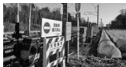
(仮称) 南古河駅予定地付近
