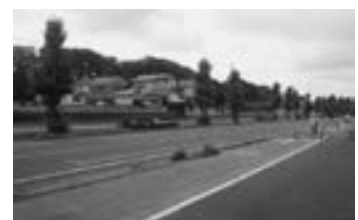
南古河駅予定地付近
