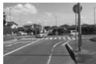
信号機がなく危険な交差点
