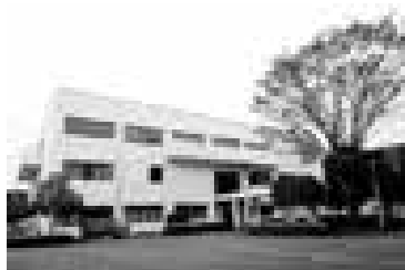
古河浄化センター
