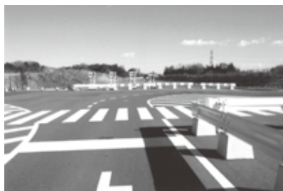
筑西幹線道路柳橋恩名線
