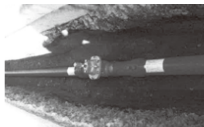
水道管布設替え工事
