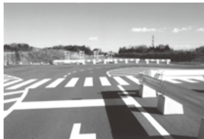
筑西幹線道路柳橋恩名線
