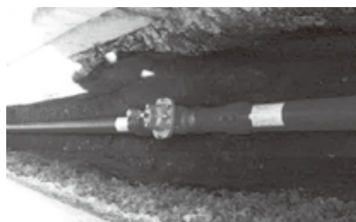
水道管布設替え工事
