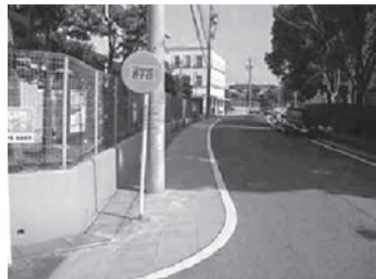
路肩のカラー舗装
