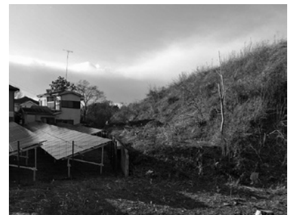
民家に迫った危険な盛土
