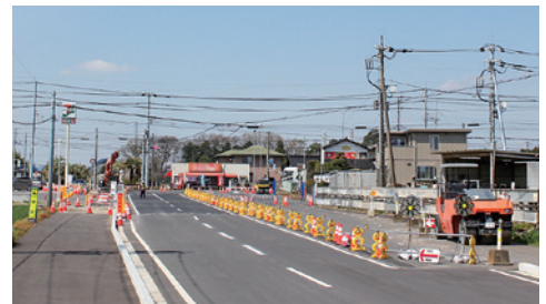
整備が進む市道柳橋下大野線
