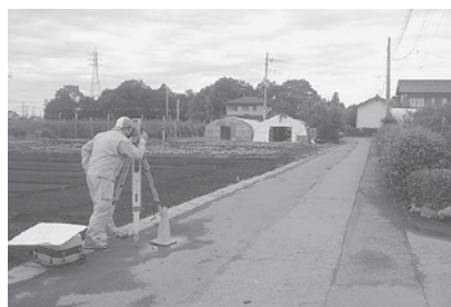
現道拡幅測量(大堤南部土地区画整理事業地内)
