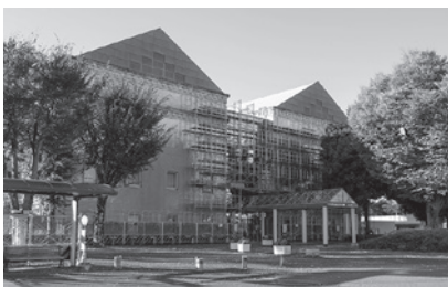
改修工事が始まった古河庁舎
