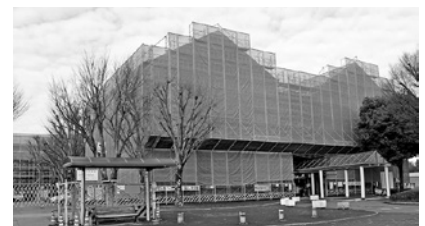
修繕工事が進む古河庁舎
