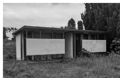
総和北中学校屋外トイレ（故障中）
