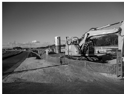
工事が進む東山田・谷貝地区
