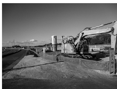
工事が進む東山田・谷貝地区
