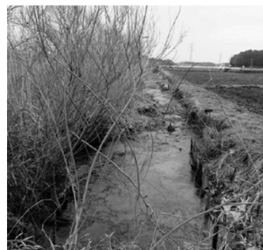
古河市側の用排水路の現状
