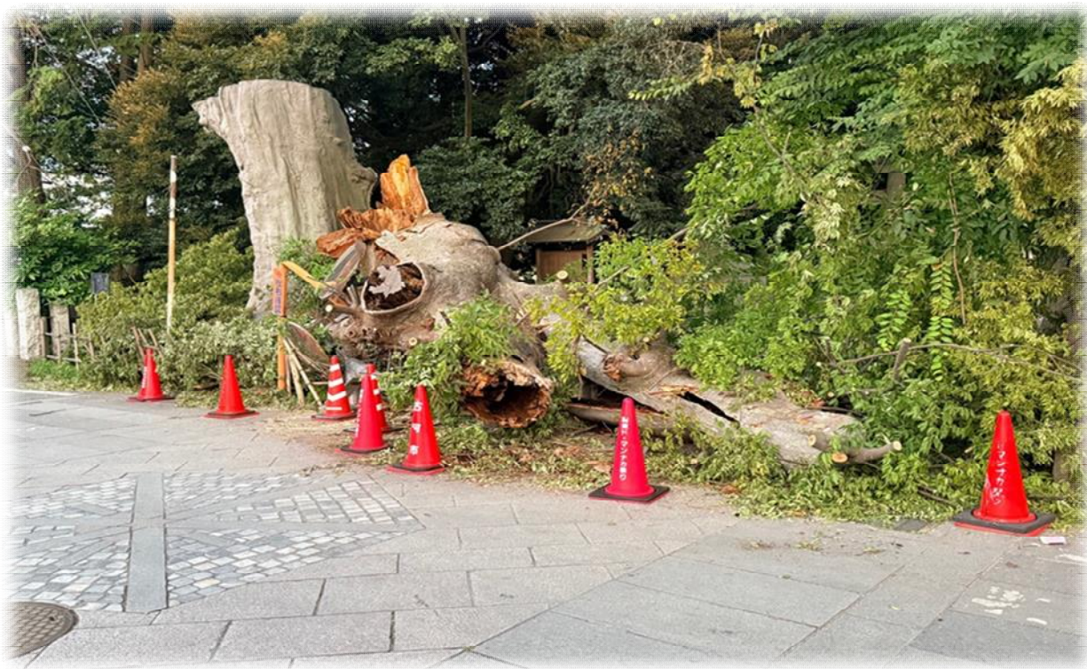
通行に支障がない状況で、当日の作業終了。当日、午後3時ごろ
