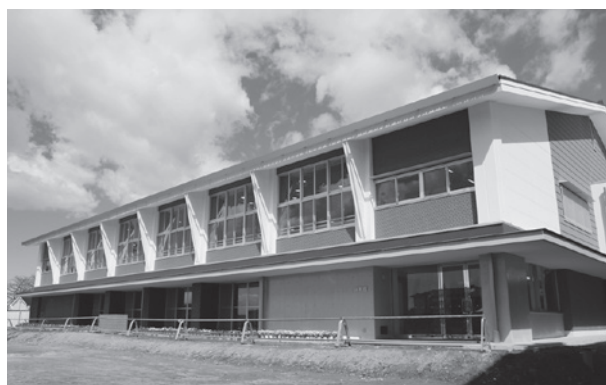
▲古河第一小学校の屋内運動場(平成28年3月完成)
