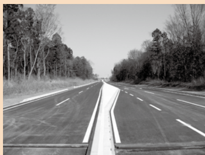
筑西幹線道路～ 柳橋より東方面を望む
