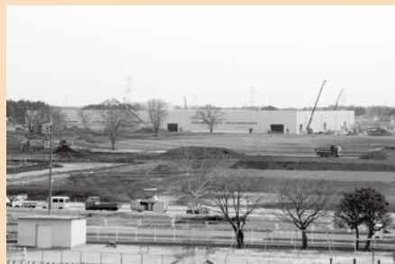
建設工事が進む古河名崎工業団地
