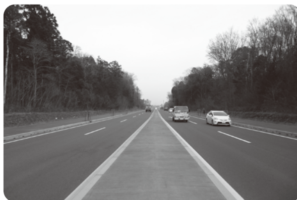
筑西幹線道路
