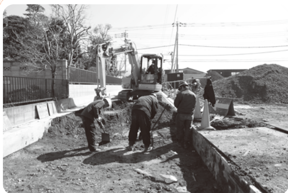
道路整備の様子
