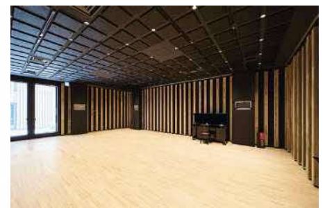
音楽スタジオ：音響配慮、ピアノ設置
